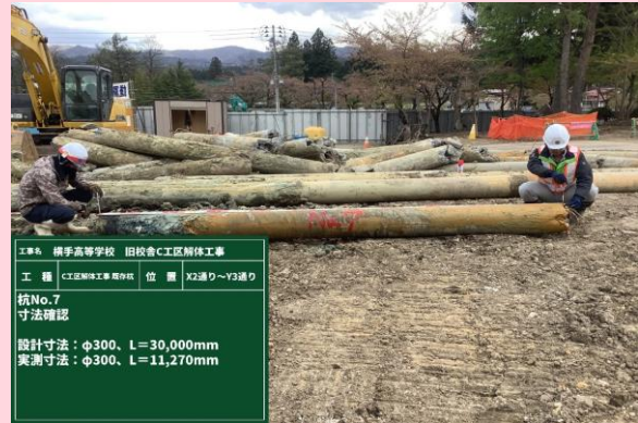
既存杭 計測状況
