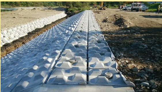
天端コンクリートブロック据付完了
