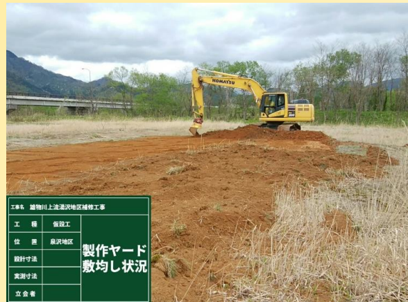
ヤード造成状況
