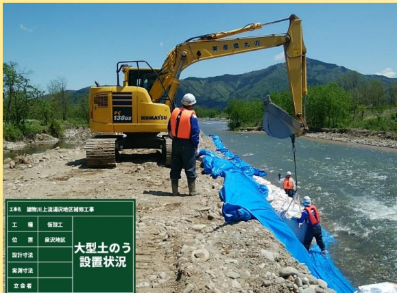
大型土のう設置状況
