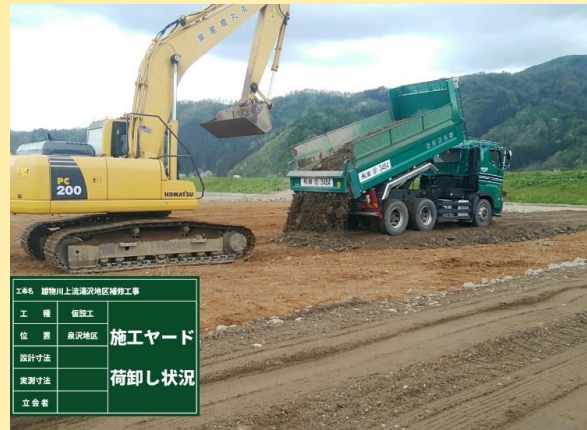
施工ヤード荷卸し状況
