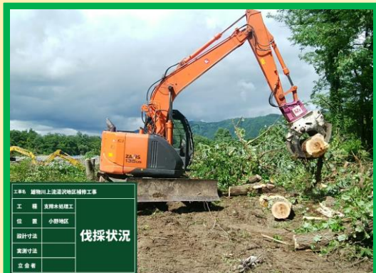
支障木伐採状況
