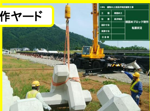
根固めブロック転置状況
