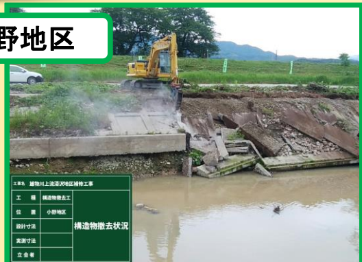
構造物撤去状況
