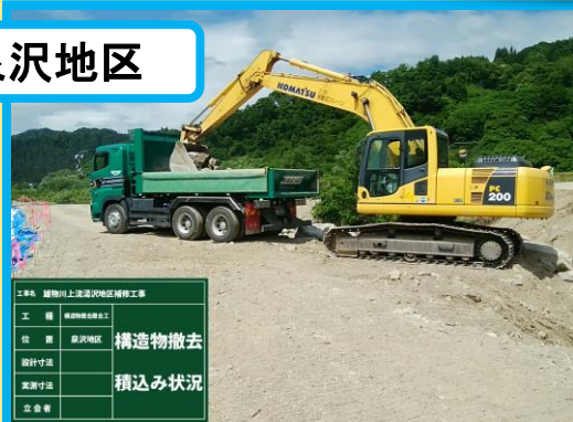
構造物撤去状況
